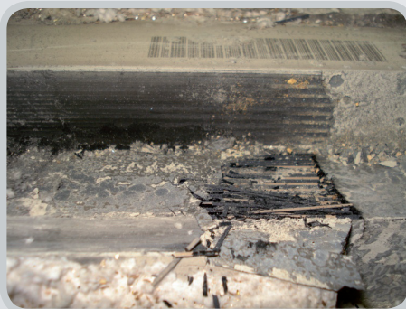
Bild Nr. 17: Komplett verstopfte Kapillaren
